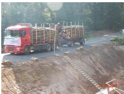
Beladener Lkw als Belastungstest (Foto: Ingenieurbüro Pabsch & Partner)
