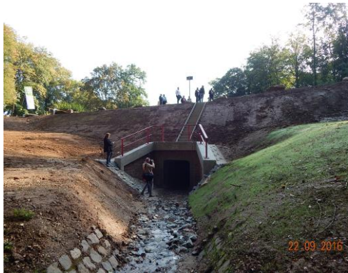
Die neue Brücke über dem Heckenbornbach (Foto: O. Sommer, Ingenieurbüro Pabsch & Partner, Blankenburg (Harz))
